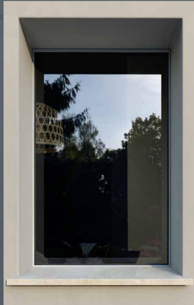
Soluzione con traverso inferiore a scomparsa all'interno del muro.
